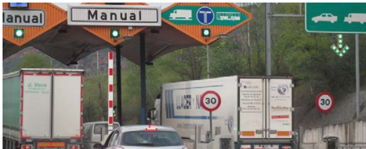
Beispiel für eine VIA-T-Station
