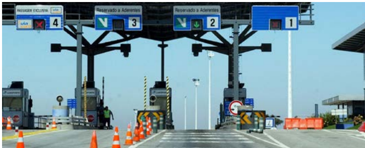
Beispiel einer VIA-VERDE-Mautstation
