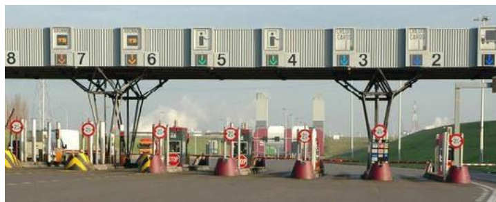
Beispiel Bahnhof „Liefkenshoek-Tunnel“ in Antwerpen
