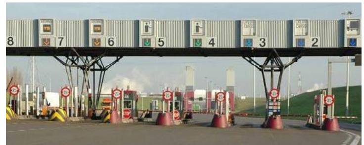
Beispiel Bahnhof „Liefkenshoek-Tunnel“ in Antwerpen
