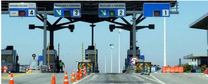
Beispiel einer VIA-VERDE-Mautstation
