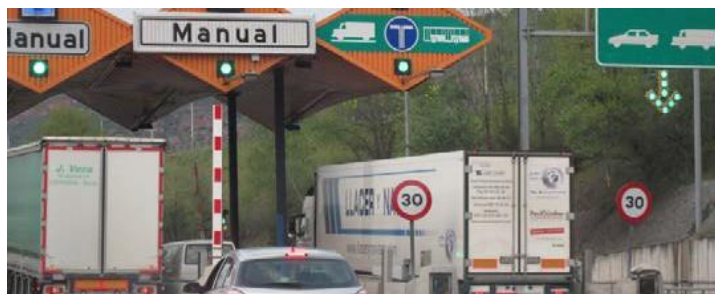
Beispiel für eine VIA-T-Station
